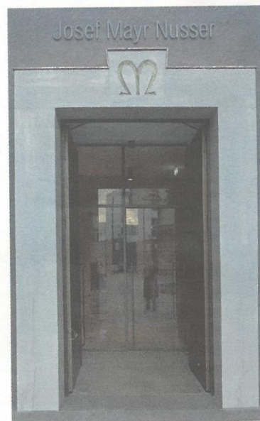
L'ingresso principale del centro Mayr Nusser in piazza Magnago
