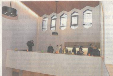
L'interno della chiesetta Regina Angelorum appena ristrutturata
