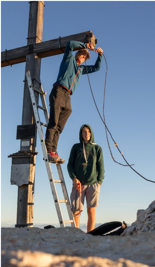
Bereits im Jahr 2017 führte die SKJ-Ortsgruppe Enneberg Instandhaltungsarbeiten am stark verwitterten, originalen Gipfelkreuz von 1988 durch.
